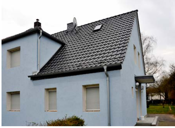
Bei der Sanierung eines Wohnhauses in Köln-Dellbrück wurde das Dachgeschoss auf den neuesten Stand der Dämmtechnik gebracht Foto: Dagmar Riefer
